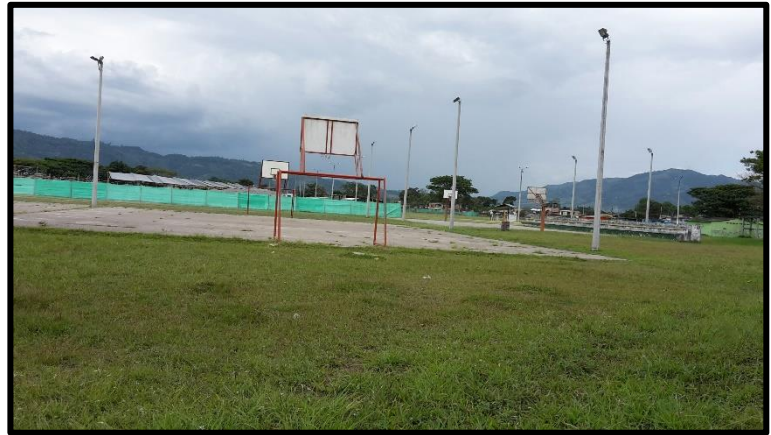
Centro Deportivo de Alto Rendimiento (En construcción)
